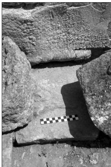
fig. 16 : Détail du dépôt de calcite en bourrelet
