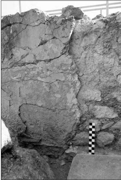
fig. 7 : Détail de l'enduit de tuileau
