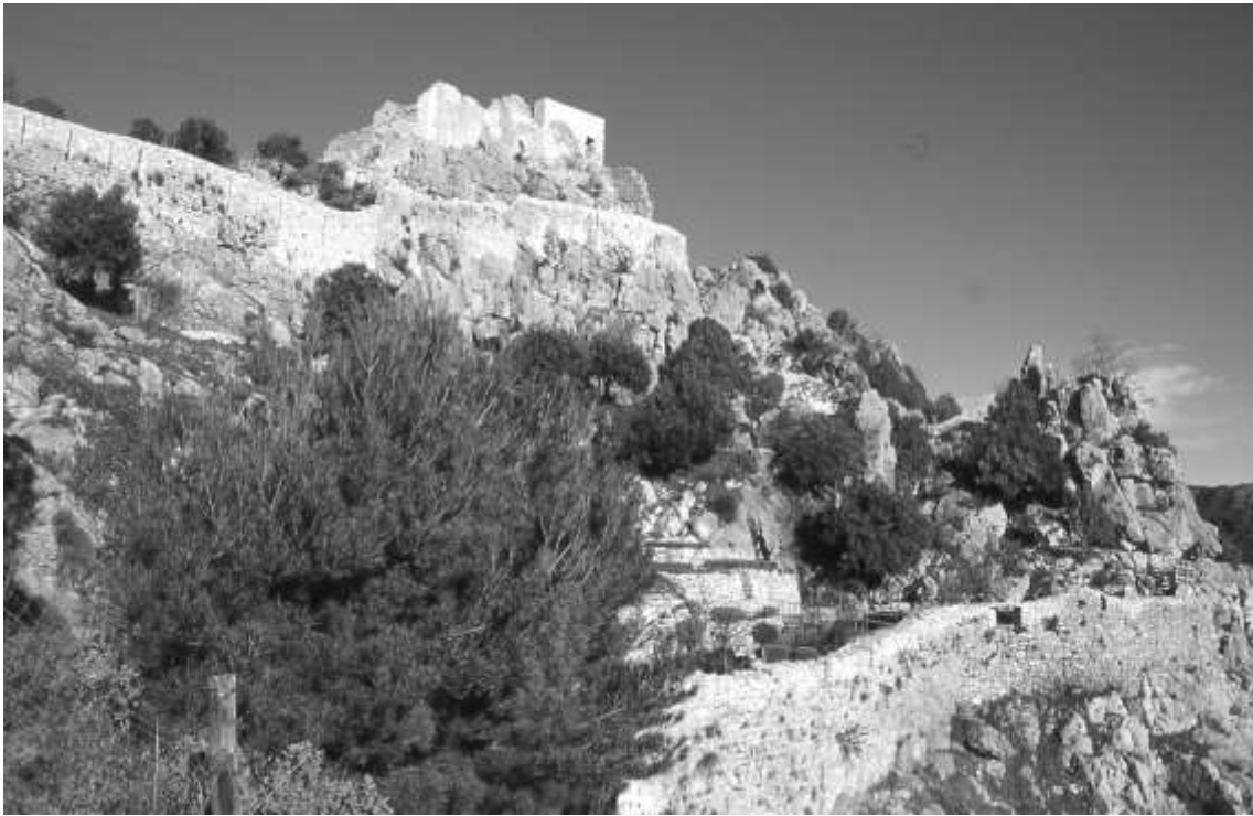
fig. 5 : L'étagement du site en trois niveaux vu du sud Au sommet : le bloc castral et sa tour restaurée
