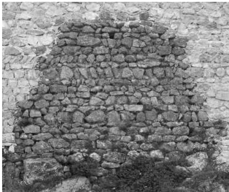
fig. 8 : Le mur 1 de la tour (NE) (Cliché : F. Blanc)
