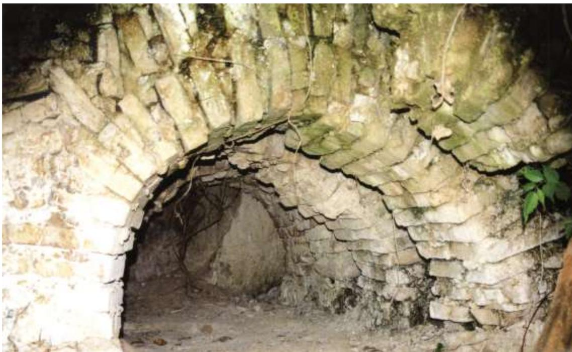
fig. 47 : Le four de Colomars : un des couloirs de la chambre de chauffe avec ses éléments porteurs
