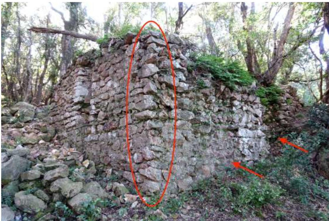
Fig. 29 : Angle nord-est et passage nord (parties dégradées signalées en rouge)
