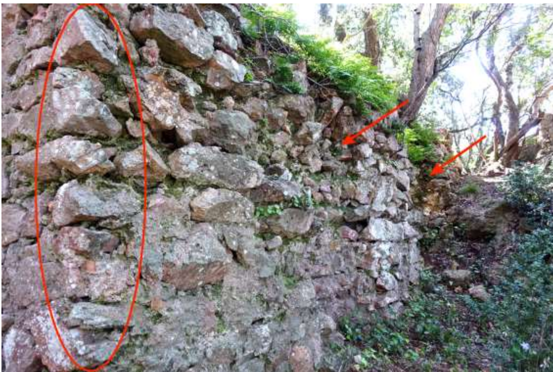
Fig. 30 : Passage nord et dégradation du parement extérieur
