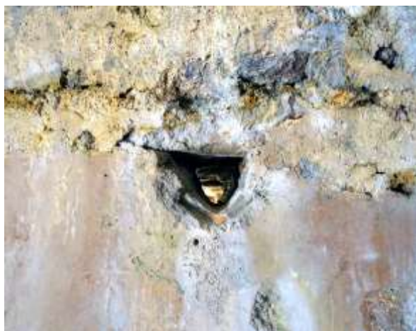
Fig. 34 : Goulotte haute dans le mur nord
