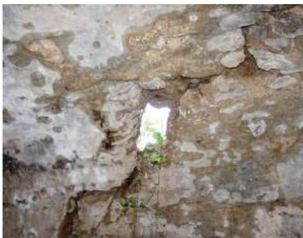
Fig. 33 : Ouverture ou effondrement du plafond
