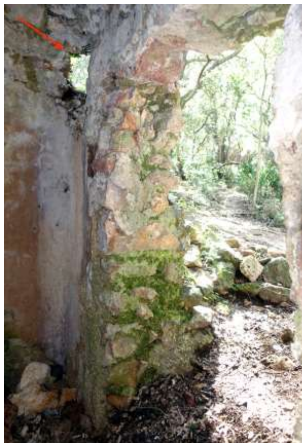
Fig. 25 : « Piédroit » sud et ouverture ou goulotte de remplissage (flèche rouge)
