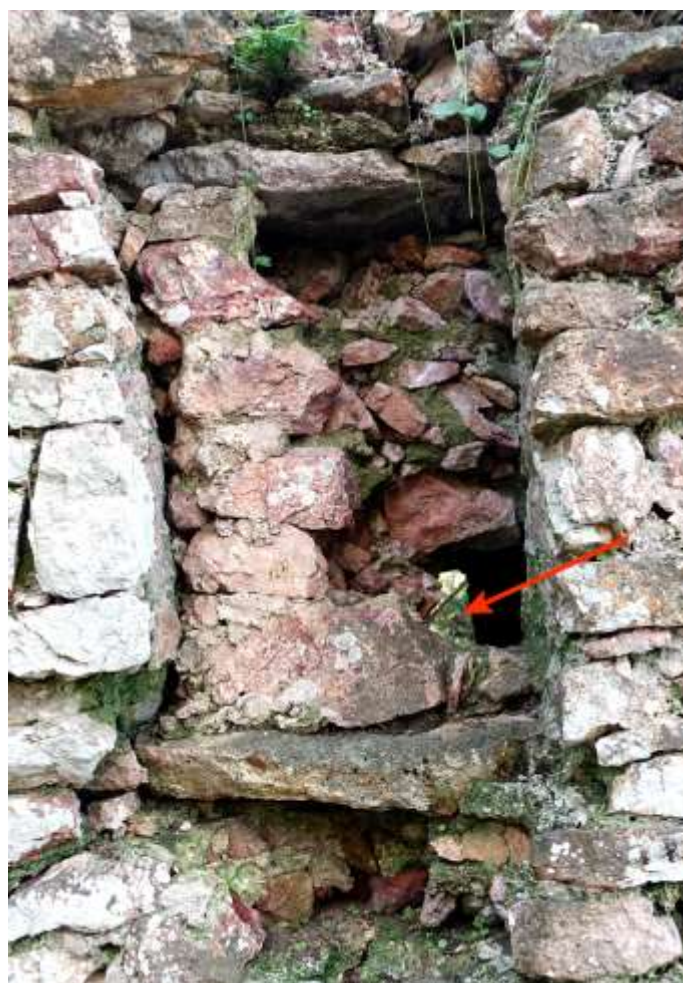
Fig. 28 : « Fenêtre » ou margelle obturée (flèche rouge : petite ouverture actuelle)
